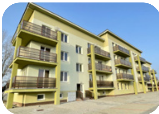
Komárno (SK) - ul. Slobody
